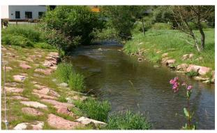
Grobsteine schützen an der Erf die Uferbereiche vor Erosionsschäden. Niederschlagswasser fließt bei starken Regenfällen über die linke Uferseite von einer Flächenentwässerung der Erf zu. Der Untergrund ist erosionsresistent mit Grobsteinen abgedeckt. Der rechte Uferbereich wird mit Steinen vor den heranrauschenden Wassermassen geschützt. Das Bauwerk war schon kurz nach Abschluss der Arbeiten wieder begrünt.
