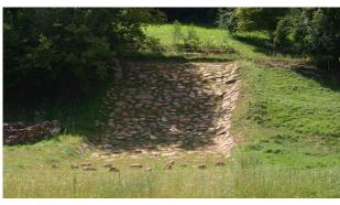
Entwässerung für starke Niederschlagswässer. Ein Baugebiet wird hier vor der Gefahr bedrohlicher Hangwässer geschützt. Das vom Berg anlaufende Oberflächenwasser wird kanalisiert und auf einer vorgegebenen Route der Erf zugeführt. Die Grobsteine wurden mit Bindemittel fixiert und dann mit Mutterboden überstreut. Kurz nach Abschluss der Arbeiten waren die Steinzwischenräume wieder begrünt.
